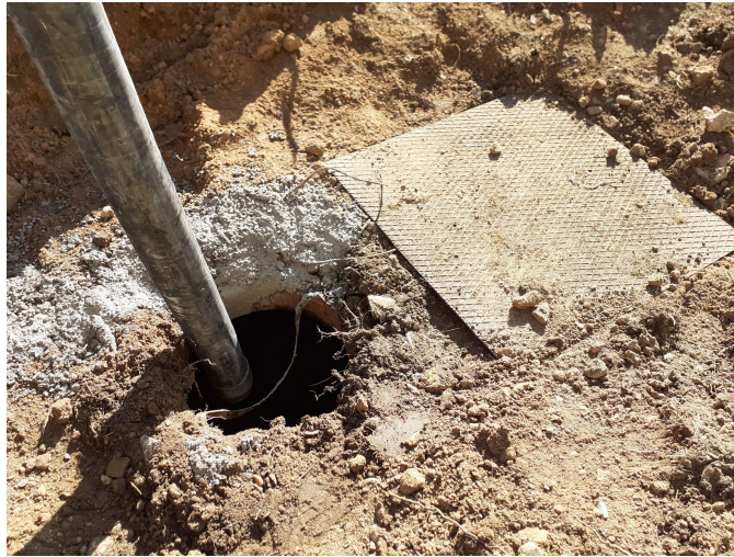
Compartiment en cours d'inertage (béton)
